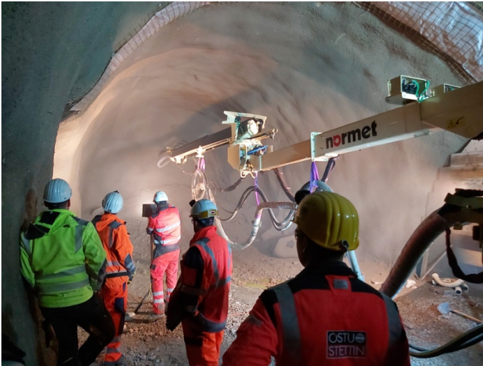
In der Tunnelbautechnikausbildung kommen modernste Maschinen zum Einsatz Foto: BFI Steiermark
